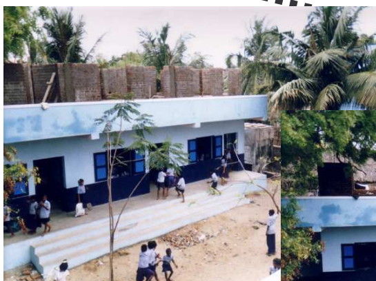
Construction d'un troisième ensemble de 3 classes
