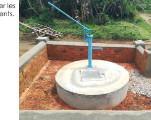
Puis c'est la pose des accessoires (pompe, tuyaux..) Un peu de maçonnerie pour protéger et embellir le tout.
